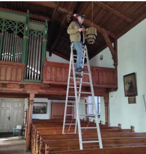
Demontage der großen Hängeleuchten
