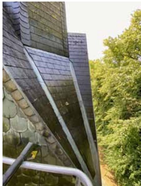
... und während der Arbeiten.
