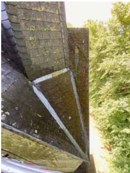
Die Turmfassade, noch nicht „gekärchert“...
